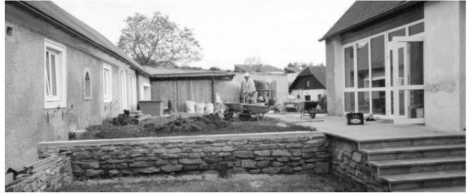
Hier erfolgte eine Erdangleichung mit Mauerabschluss, die Pflasterung des Gehweges sowie Elektroarbeiten für den Torantrieb und die Gartenbeleuchtung.
