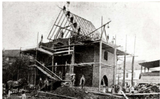
Bau des Chorraumes und Errichtung des Dachstuhles (ca. 1901)
