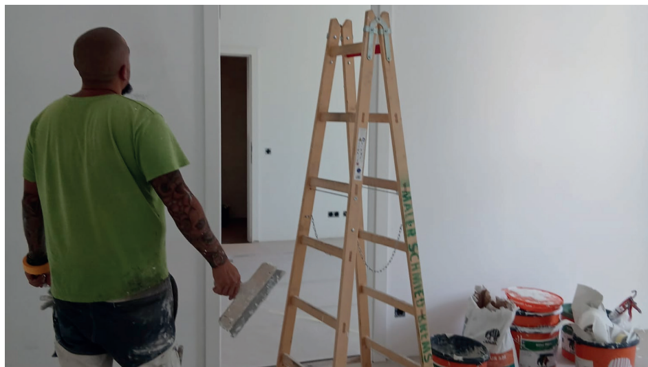
Die Wohnungen im Pfarrhaus werden zurzeit für unsere neuen Kapläne renoviert
